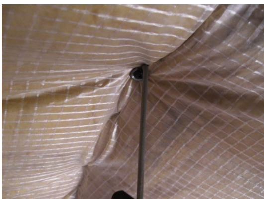
Perforace parozábrany kotevními prvky
