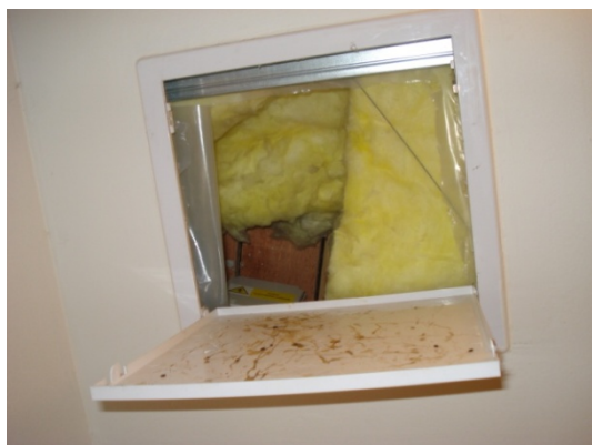
Poškození nevhodně umístěné parotěsné vrstvy při dodatečné montáži elektroinstalací
