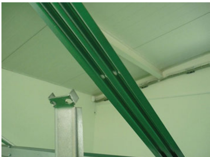
Spojení střešní výztuhy (24) a střešního sloupku (15).
