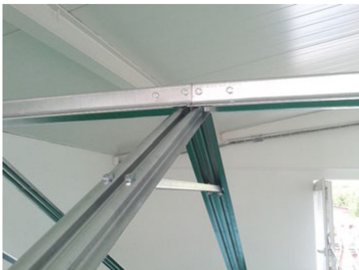
Pohled na hřeben skleníku.
