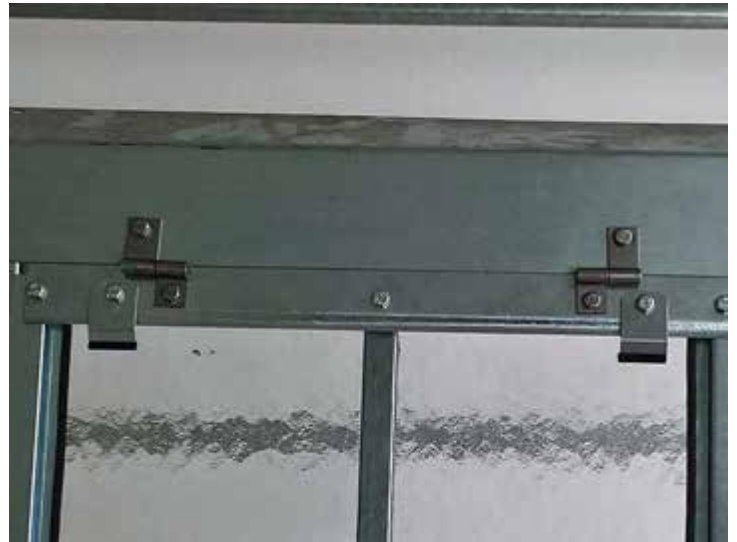
Pomocí kleští jemně přitlačíme přichytku (poz. 83-1)
