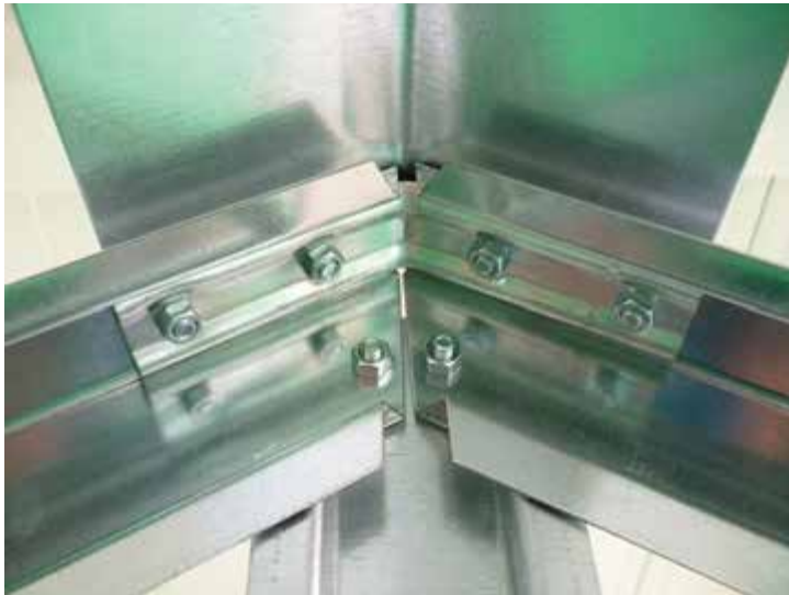
Detail spojení hřebenových plechů a štítu.
