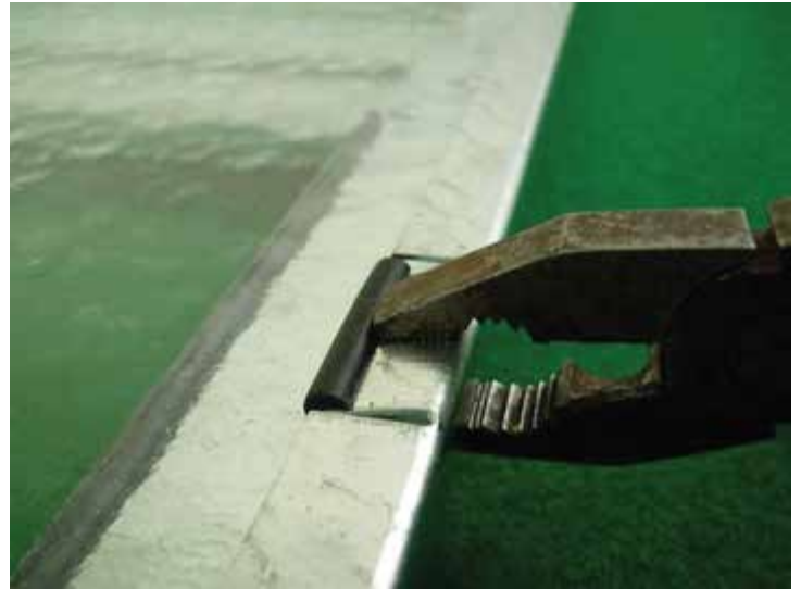
Pomocí kleští jemně přitlačíme přichytku (poz. 83-1)
