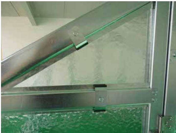
Přichycení skla k pozici 72 příchýtkou 83-1 a 83-2
