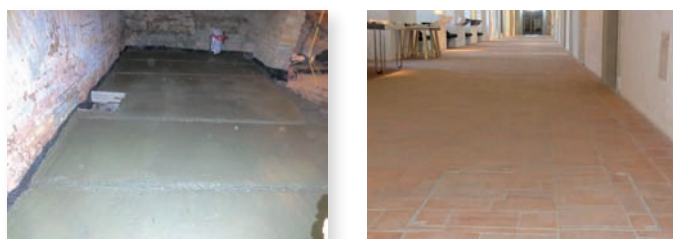
9 Výstavba nebo montáž nášlapné vrstvy podlahy, včetně uložení rozvodů vody, elektřiny a podlahového vytápění.
