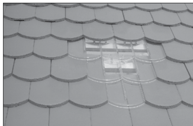
Detail prosvětlovací tašky ve střeše
